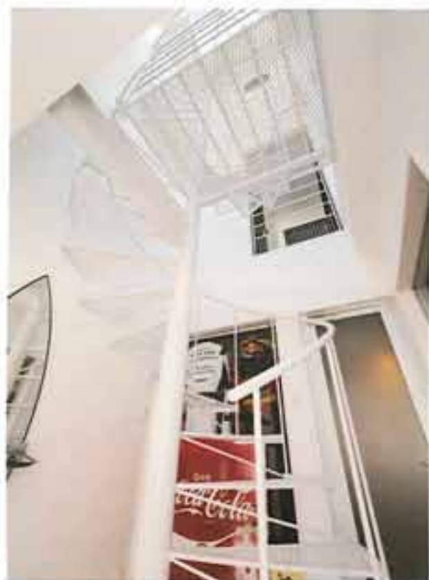
どうしても欲しかったのが螺旋階段。狭いスペースを利用して設置できるのが最大の魅力。既製品ではサイズがあわず、特別のオーダー品で対応した。
